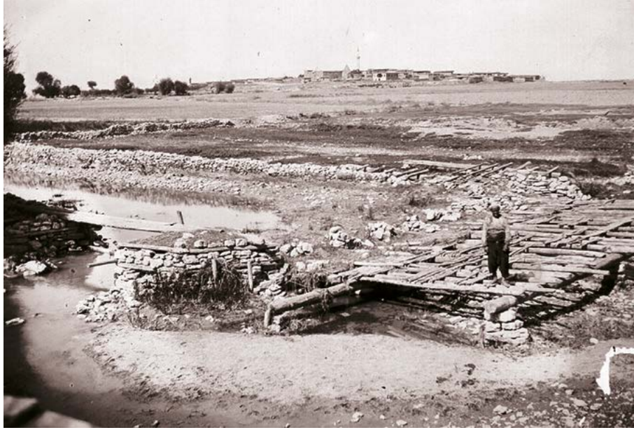
Fotoğraf 4: Beyşehir Köprüsü İnşaatı. (BBA)
